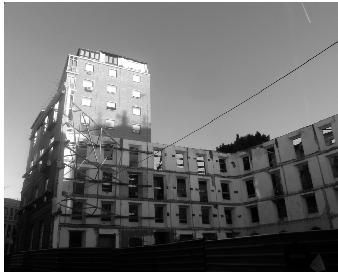
Ejemplo de actuación de rehabilitación en las proximidades de la Casa Invisible
